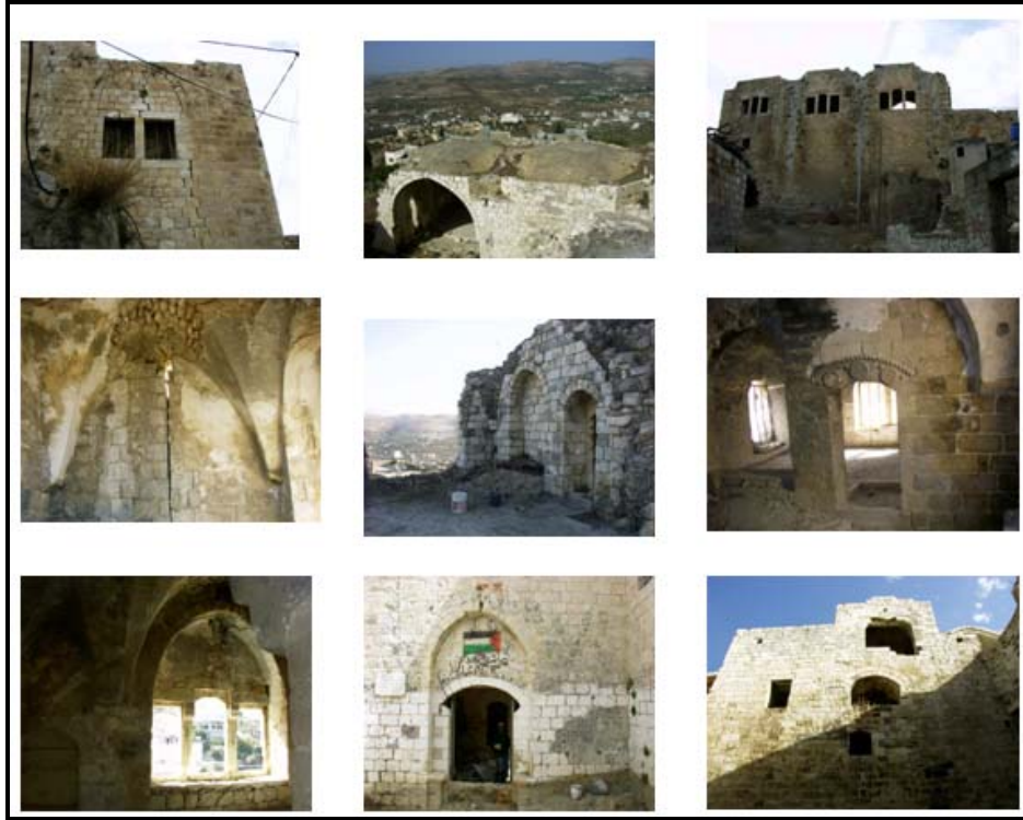
شكل (4:58): صور توثيقية قبل البدء بالترميم.
