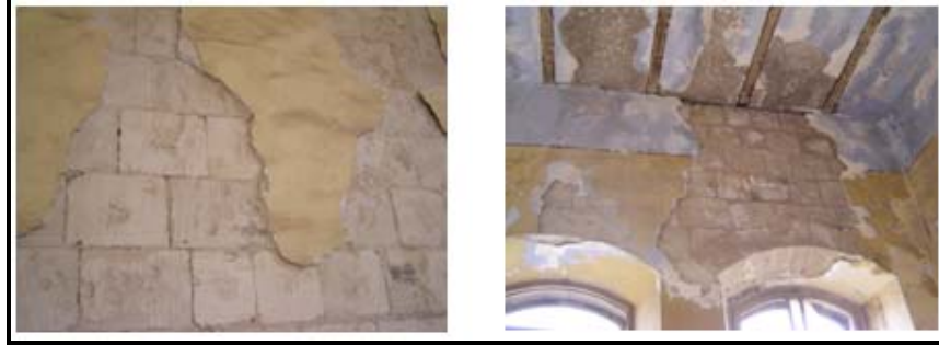
شكل (4:81): صورة توضح القسارة التي تغطي الواجهات الداخلية.
