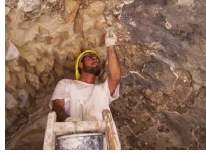
شكل (30:4): تنظيف الحجر بعد الحقن باستخدام الماء.
