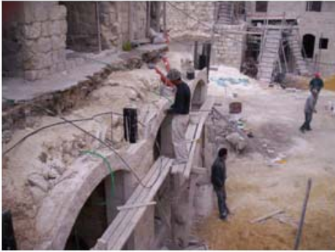
ربط الواجهة الجديدة بالقديمة
