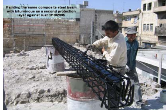
شكل (14:4): التوثيق الإنشائي أثناء الترميم.
