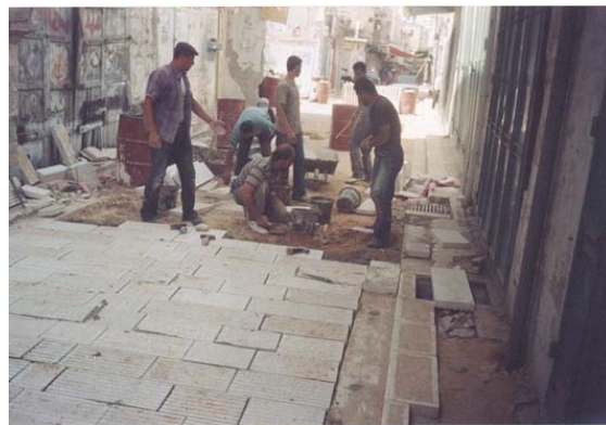
شكل (4:4): تبليط الشوارع في البلدة القديمة.
