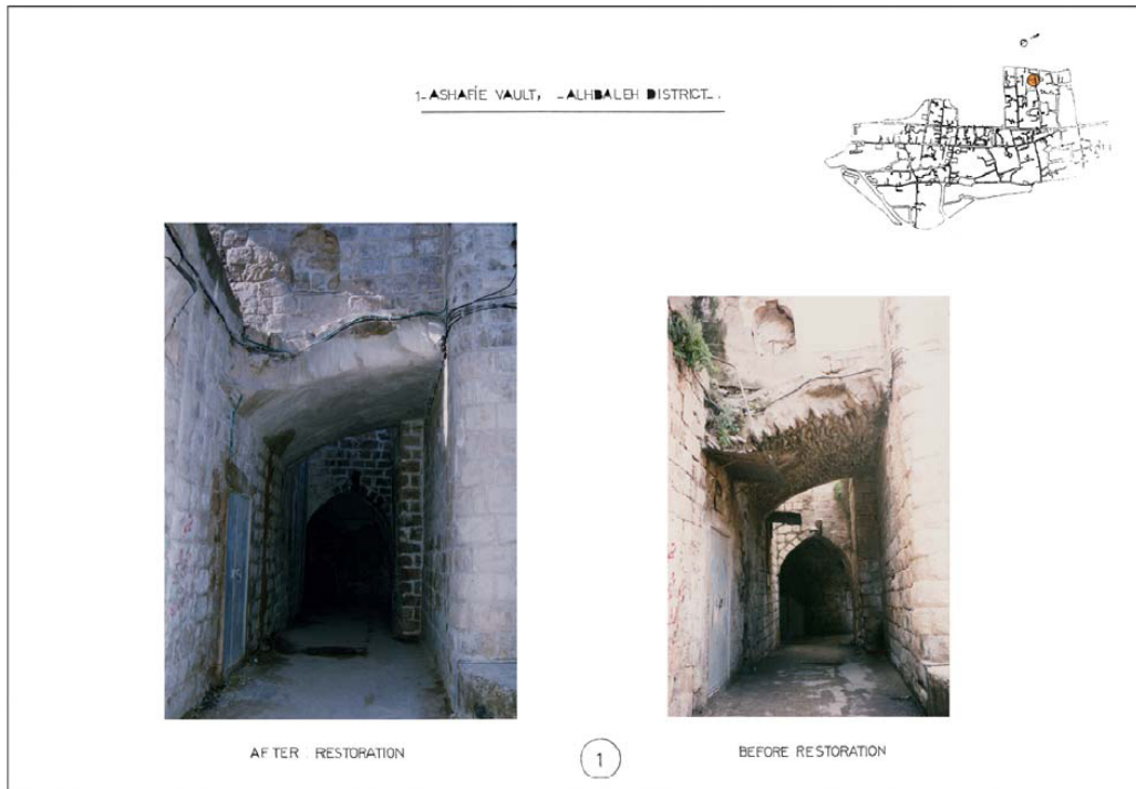
شكل (2:4): قنطرة الشافعي قبل وبعد الترميم.
